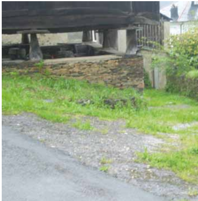
Camino antigua casa del valle-bar de Juan en Trelles
