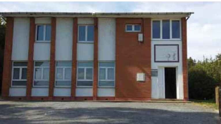
Edificio de la Escuela de Música.
